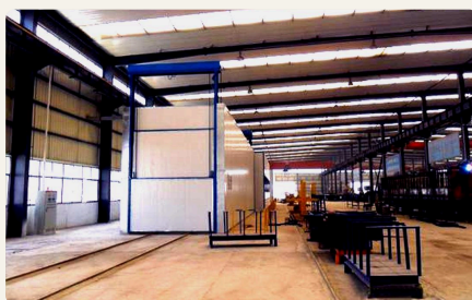
HALL DE L'ATELIER — UNITÉS EN FABRICATION
